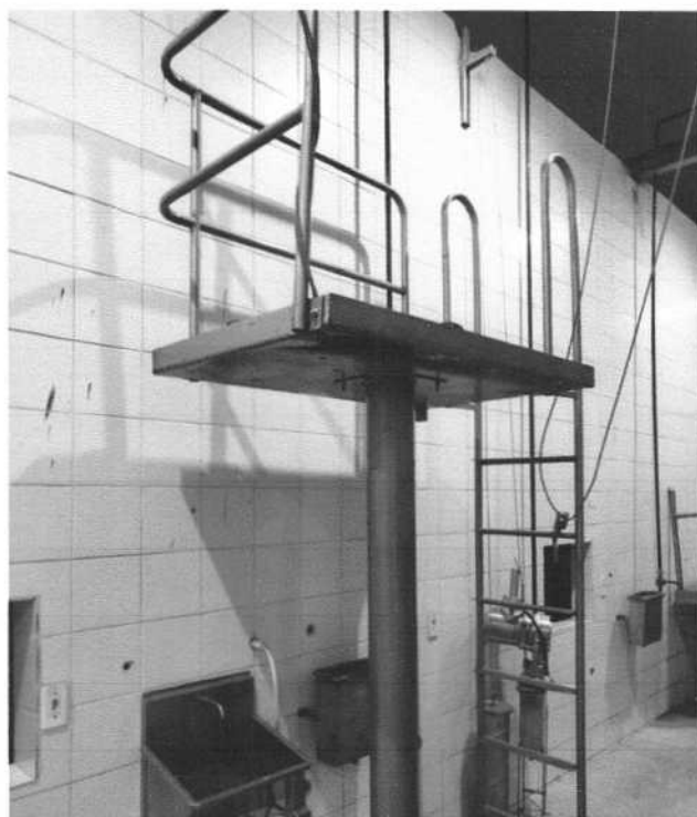
PLATAFORMA PARA RETIRADA DE MOCOTÓS E COUREAMENTO ALTO
